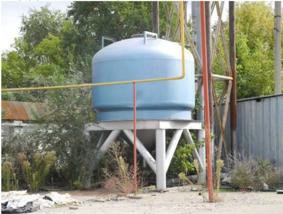
Резервуар для воды - диаметр – 2,730 мм
